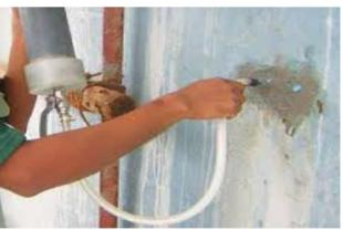
Após pelo menos 24 horas de secagem do Epocret 151, começar a injetar o Epocret 129, sempre da parte mais baixa, até as partes mais altas, até sua completa aplicação. Após 48 horas, remover os bicos de injeção e dar acabamento. Misturar a quantidade de Epocret 129 que consiga aplicar em no máximo 20 minutos por vez.
