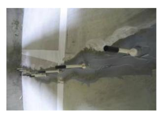
Cobrir toda a rachadura com o Epocret 151, tomando-se o cuidado de vedar completamente a fissura e em tornos dos bicos aplicadores.
